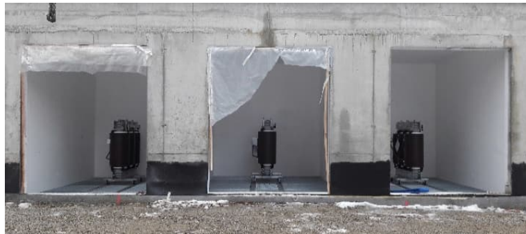
Einbringung der Transformatoren
