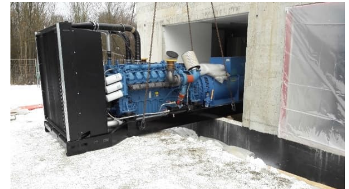
Einbringung der Aggregate
