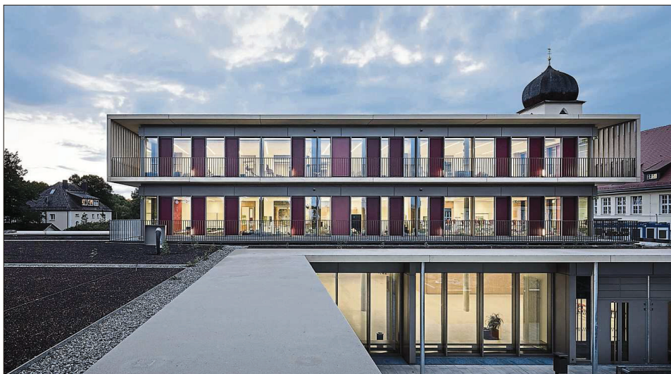
Die neue Grundschule an der Grandlstraße wurde vom Architekturbüro Auer Weber, München, geplant.
