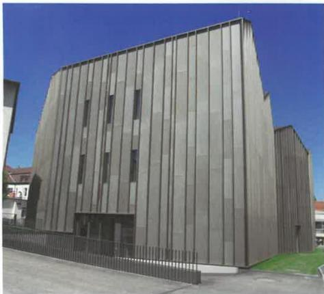
Der Laborneubau umfasst rund 2.000 m<sup>2</sup> Fläche auf drei Etagen. Es enthält neben vielen Versuchsständen auch einen 30 m<sup>3</sup> großen Wärme- und einen 40 m<sup>3</sup> großen Eisspeicher.
