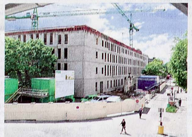
Noch nackt und grau: Der Rohbau ist weitgehend fertig, jetzt geht es darum, die Klinik innen auszubauen.
