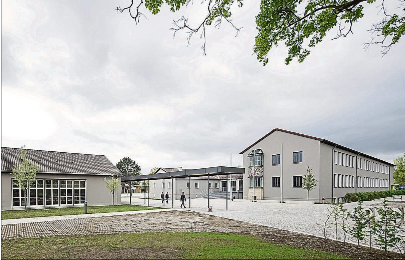
31,5 Millionen Euro wurden in die Erweiterung und den Umbau der Staatlichen Berufsschule Bad Aibling investiert.
