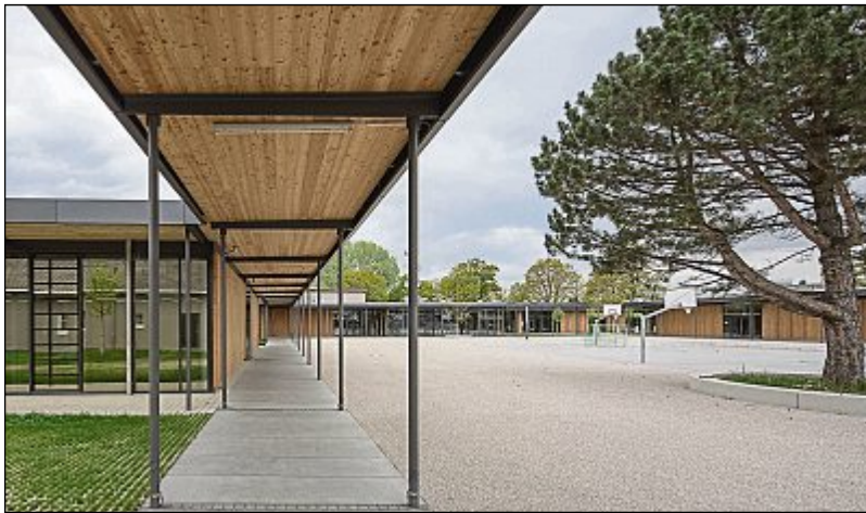
Die offene, überdachte Pergola.
